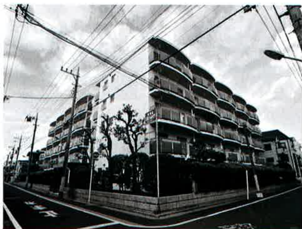
図20 事例2 葛飾区立石の立石シティハイツ 全景 南西から
