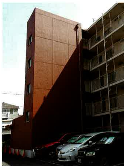
図15 事例1 東村山市富士見町のパイロットハウス東村山 着工前 南から
