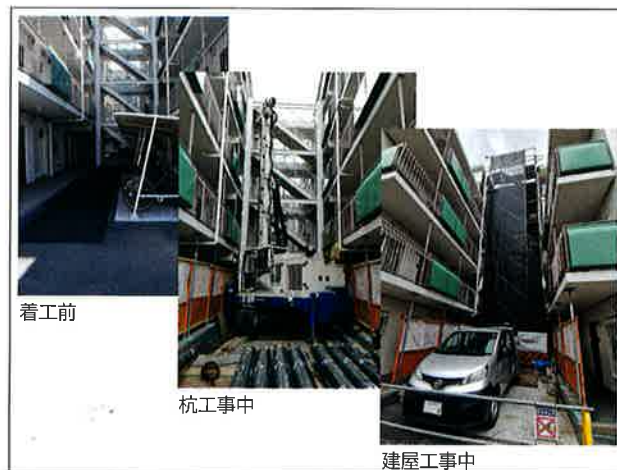
図21 事例2 葛飾区立石の立石シティハイツ 着工前～工事中
