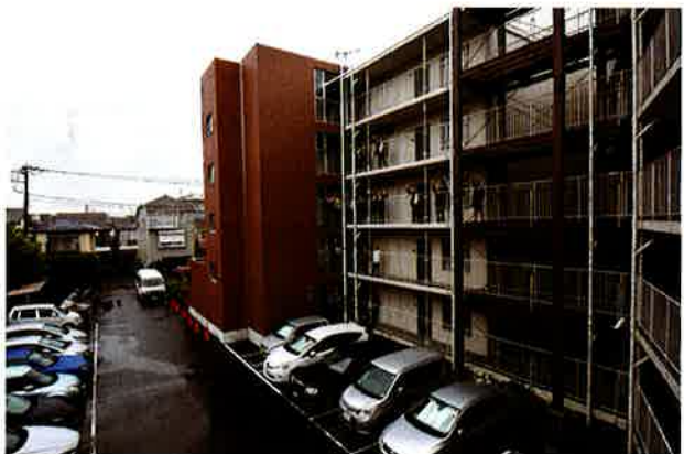
図16 事例1 東村山市富士見町のパイロットハウス東村山 竣工後 南から
