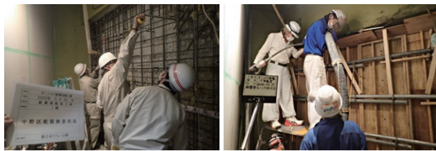
1階での耐震壁設置工事
