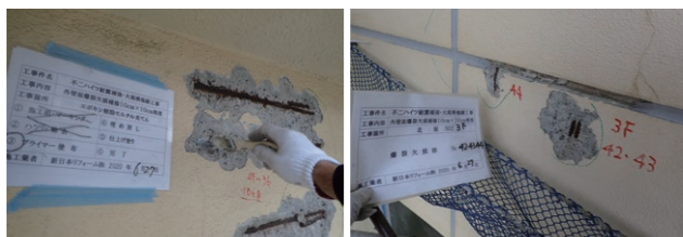
建物全体で行われたひび割れ補修工事
