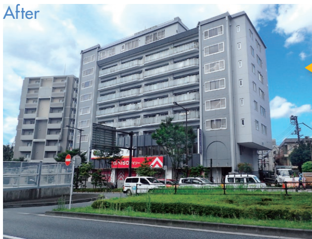
地上9階/地下1階建てのFマンション。1階に耐震壁を設置し、屋上にあった受水槽を撤去、外壁のひび割れ等を補修し、同時並行した大規模修繕工事で新たに塗装した後は、外観的にはほとんど変わらないもののイメージは大きくリフレッシュされた
